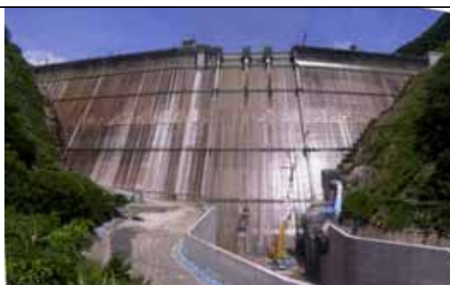
下流から見た長井ダム(H18.8月撮影)
