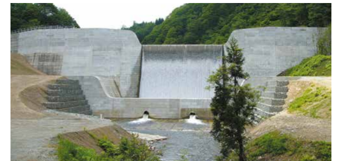
入間砂防えん堤 (西川町) (地図 P.9)
