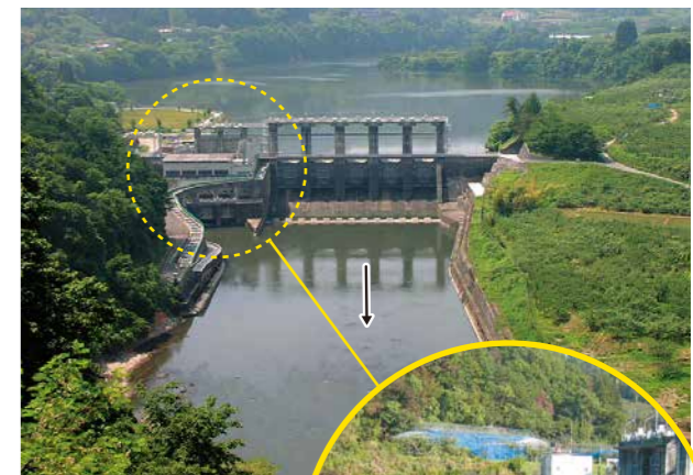
朝日町の最上川にある 上郷発電所（上郷ダム）
