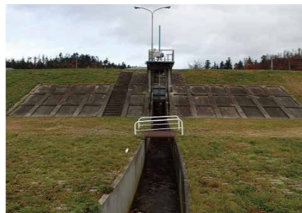
河島排水樋管
