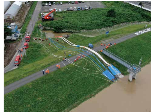
最上川・排水作業 (河北町押切)
