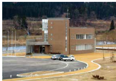
4 真室川河川防災ステーション
