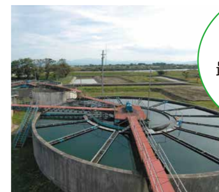
酒田市にある工業用水道の施設
