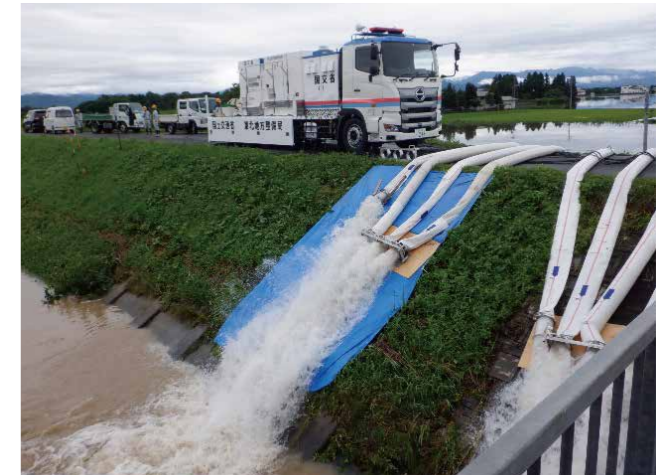
最上川・排水作業 (川西町西大塚)
