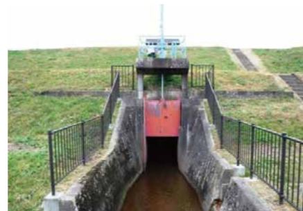
菖蒲排水樋管
