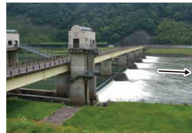
2 最上川さみだれ大堰
