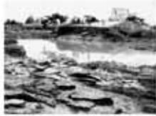
【中山町】 昭和12年夏、上川手前の濁流洪水。 延長90m、高さ1m(中山町長崎橋手前)
