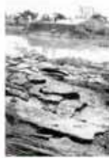
【中山町】 昭和12年夏、上川手前 の濁流洪水。延長約1km、高さ約1m (中山町長崎橋手前)
