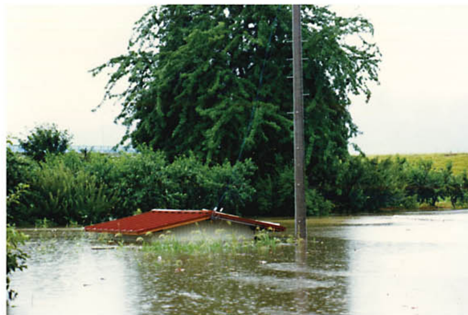
■ 一級河川 荒神川 荒神社前 揚水ポンプ小屋(昭和61年8月5日)
