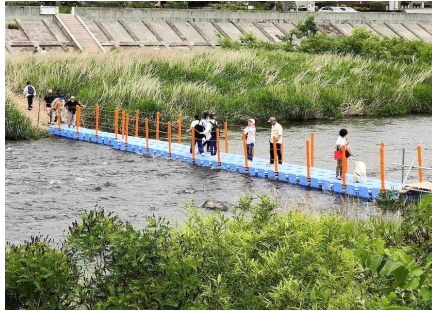
3日間設置した浮棧橋
