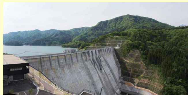
寒沢展望台から ダム堤体、管理所を望む
