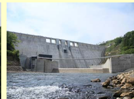
下流河川からダム 堤体を望む
