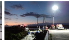
災害対策用機械による災害対策支援
