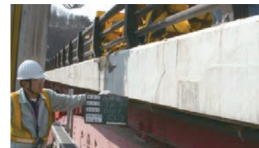
地覆補修時の状況
