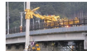
道路・河川施設の点検・診断・予防保全対策の検討
