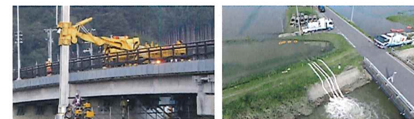
道路・河川施設の点検・診断・予防保全対策の検討
