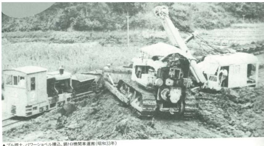
▲ブル押土、パワーショベル積込、錫トロ機関車運搬(昭和33年)
