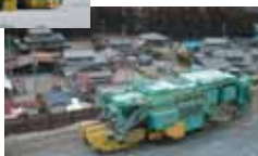
住宅近接部での施工
