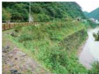
施工7年後のダム湛水面の法面
