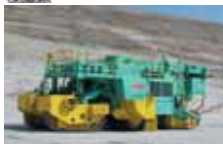
岩盤切削工法の実景
