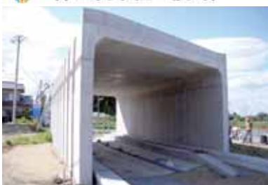
国道4号 築館バイパス(7.3×4.8) 東日本大震災で震度7に耐える
