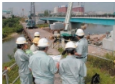
工事現場へ赴く生徒たち
