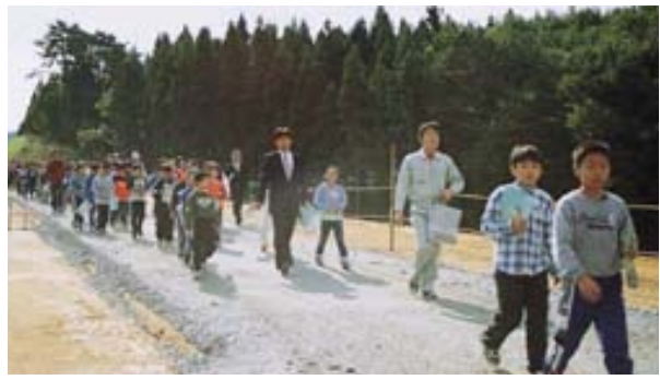
工事現場を元気に歩く生徒たち
