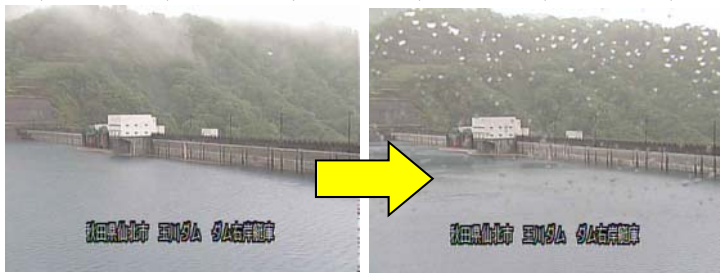
防災操作開始前の 貯水位 EL. 397.22m
