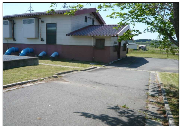
流川排水機場 (高瀬川河川事務所所管施設)
