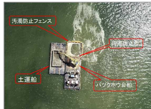
砂の投入状況(試験施工時)
