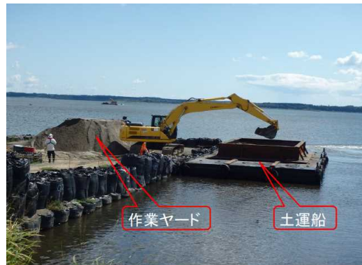
砂の積込状況(試験施工時)
