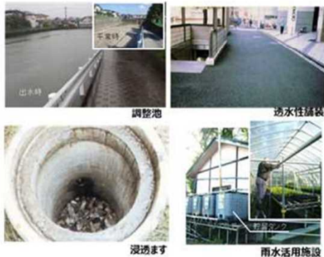
雨水貯留浸透施設の例
