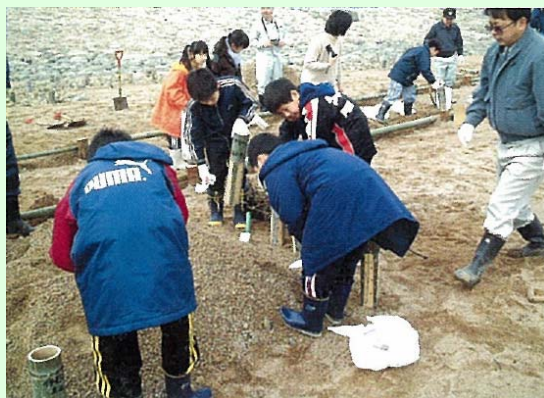
竹ポットの据え付け
