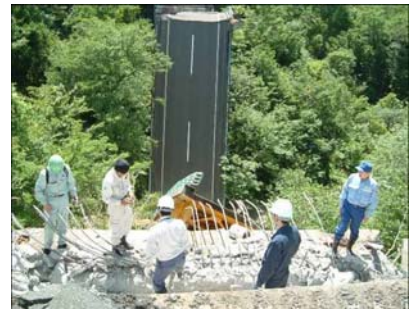
12 図 17 岩手・宮城内陸地震(H20.6)における 13 被害状況(祭時大橋)
