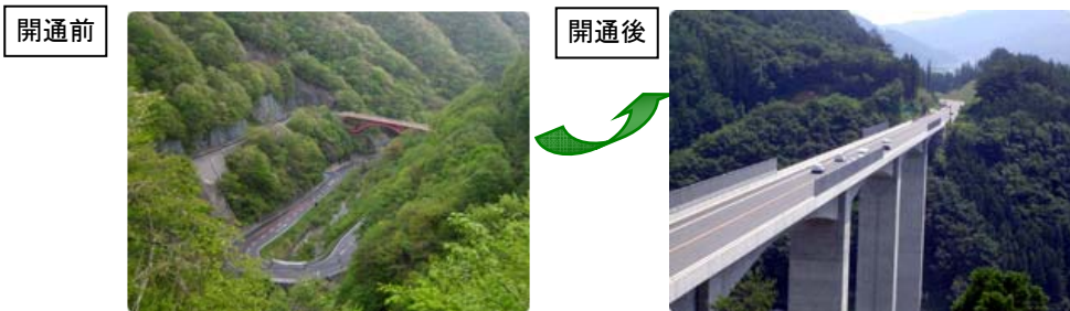
図 36 東北横断自動車道釜石秋田線(仙人峠道路)の開通(H19.3.18)
