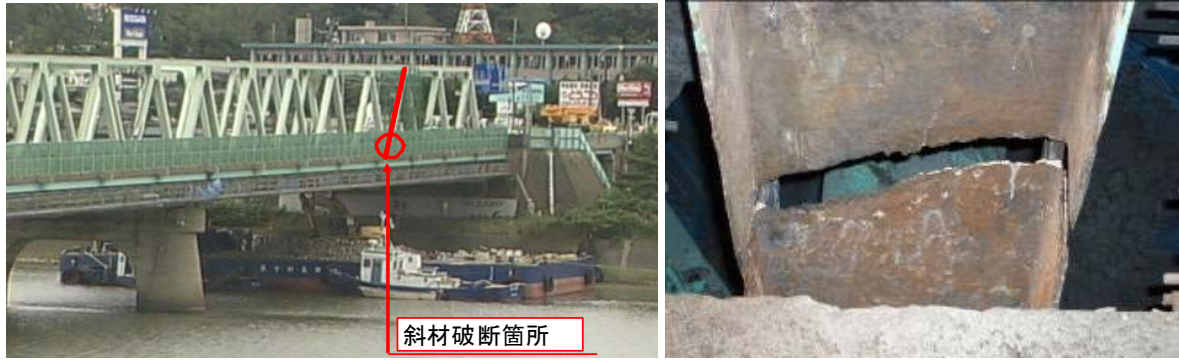
図 32 本荘大橋斜材破断
