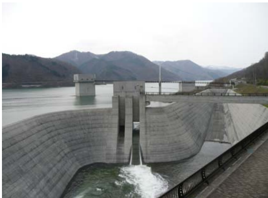
平成26年の越流状況（管理所からの眺め）
