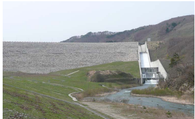
平成26年の越流状況（ダム下流からの眺め）
