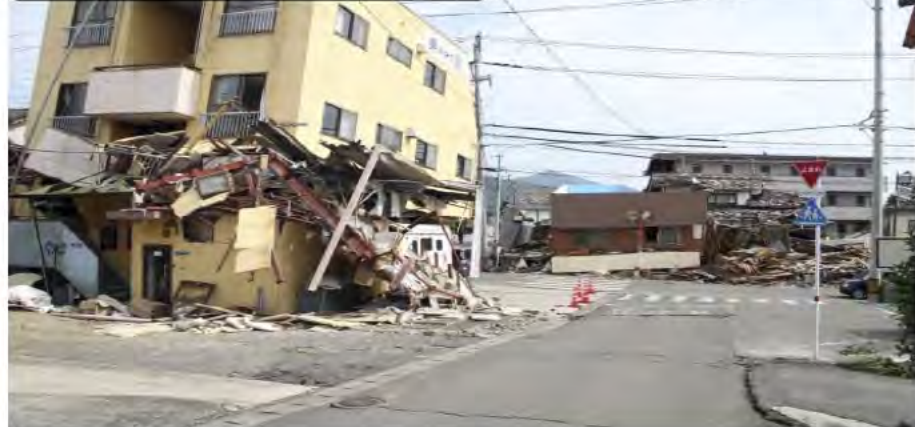
下町地区の家屋倒壊状況
