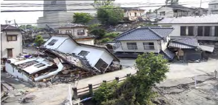
寺迫地区の家屋倒壊状況
