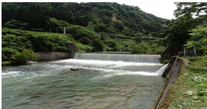
木遠田砂防堰堤
