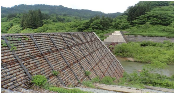
日陰倉第2砂防堰堤
