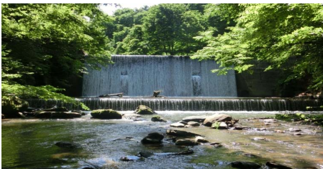
鹿の沢砂防堰堤
