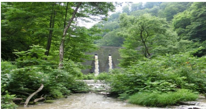
中沢砂防堰堤
