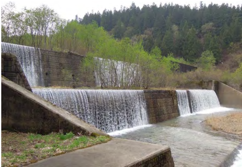
玉川第7砂防堰堤
