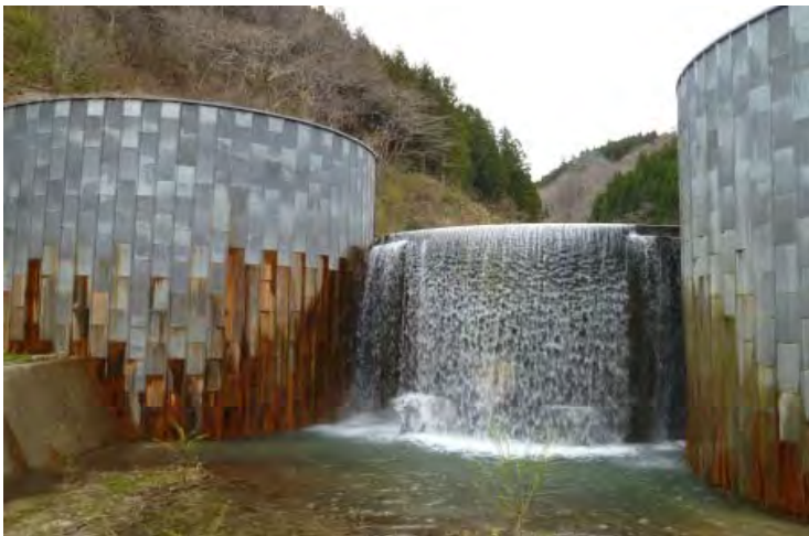
板敷川砂防堰堤
