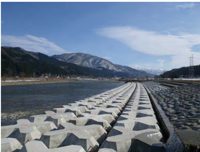
立谷沢川流路工
