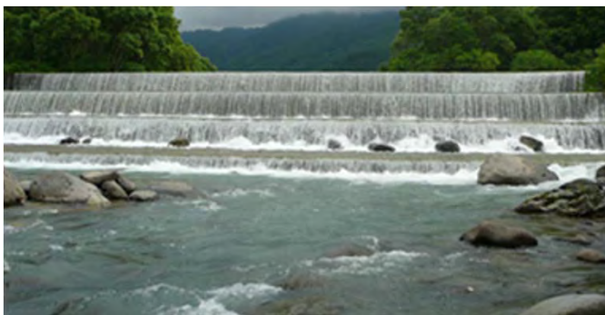
瀬場砂防堰堤
