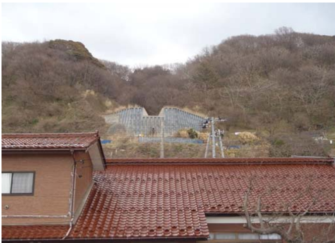
落沢砂防堰堤
