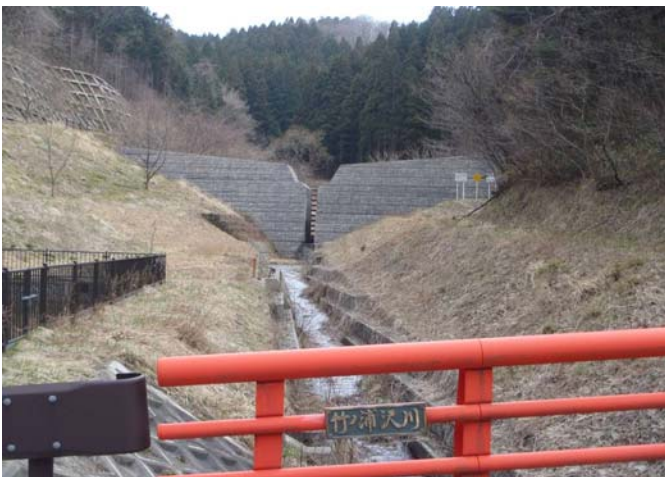
竹ノ浦沢川2号・3号砂防堰堤
