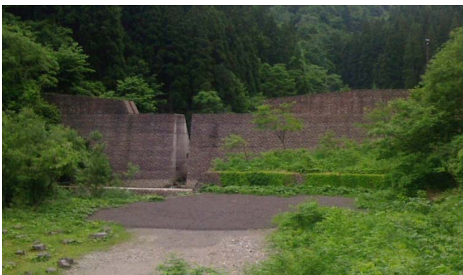
金打沢砂防堰堤
