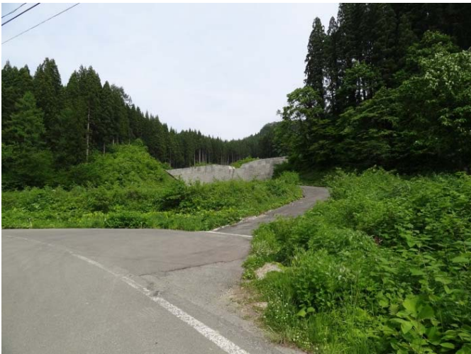
入水沢砂防堰堤
