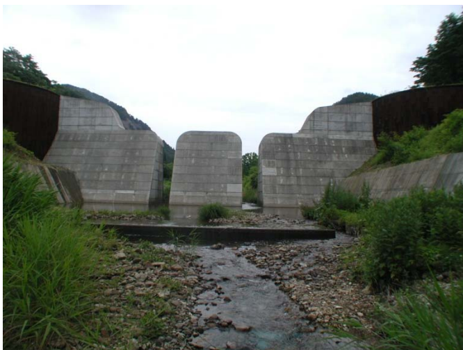
後川第3砂防堰堤
