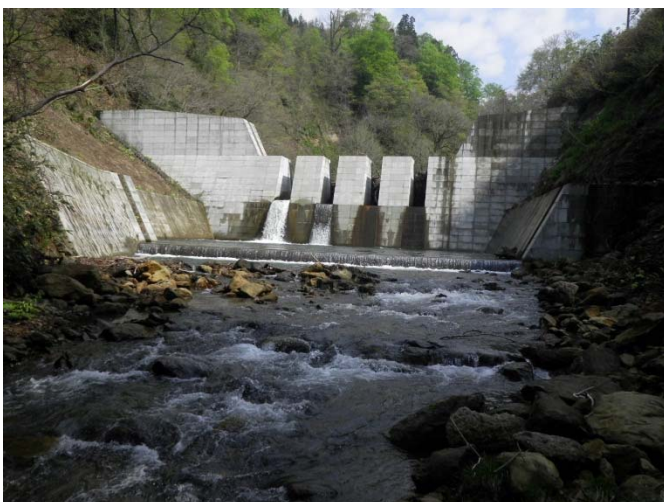
万助川砂防堰堤
