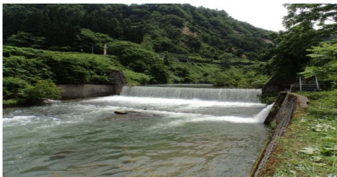
木遠田砂防堰堤
