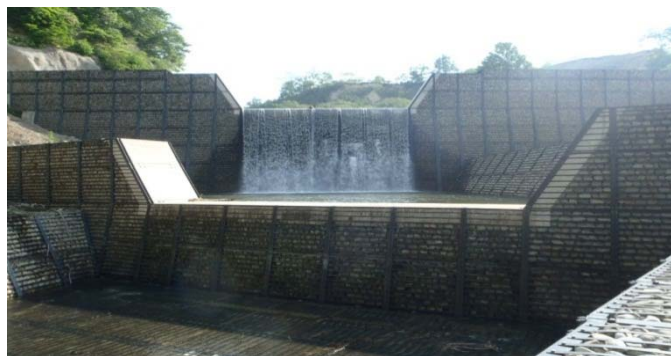
横道沢第5砂防堰堤
