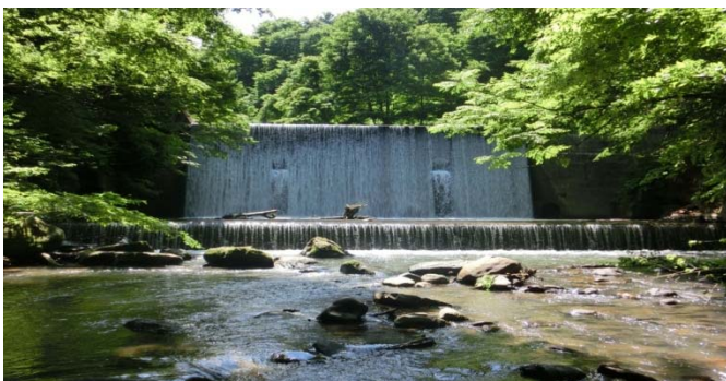
鹿の沢砂防堰堤
