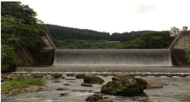
柳淵砂防堰堤
