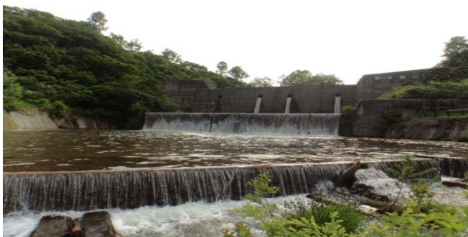
苦水第一砂防堰堤
