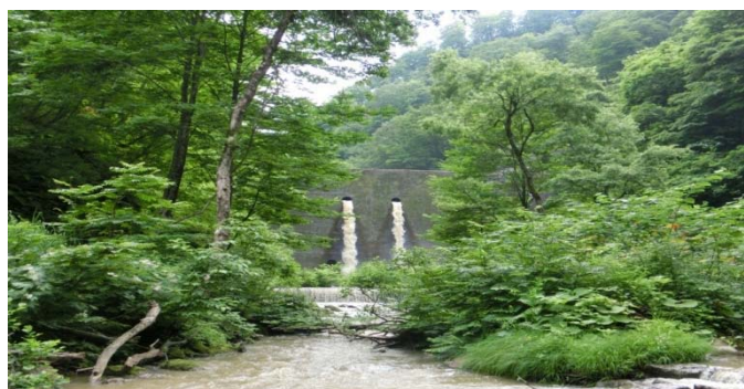
中沢砂防堰堤
