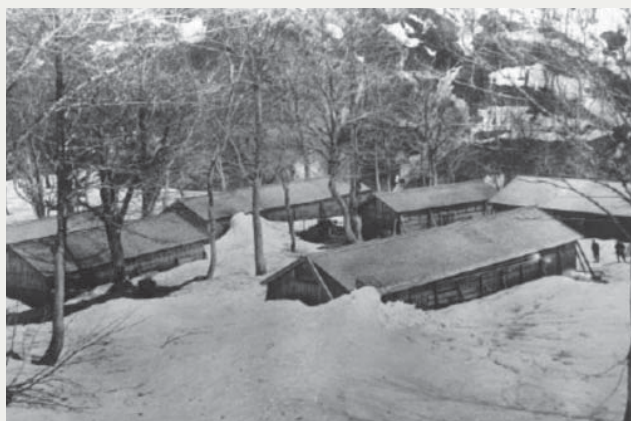
昭和16年4月の立谷沢砂防工場
