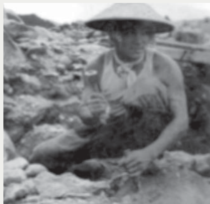
昭和24年頃の六淵砂防堰堤の工事の様子
