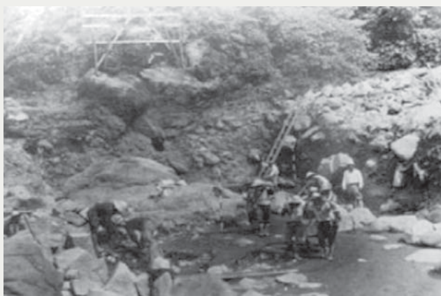
昭和13年頃の濁沢第1砂防堰堤の工事の様子
