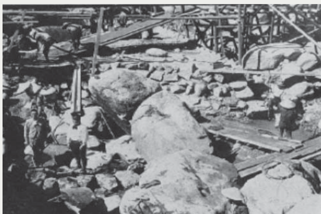
昭和15年頃の濁沢第2砂防堰堤の工事の様子
