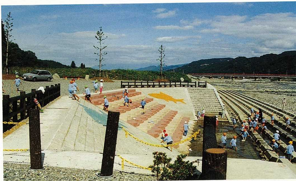
多目的広場（木ノ沢橋左岸上流付近）
