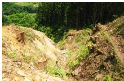
えん堤着工前
