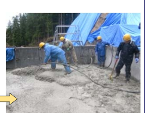
コンクリート打設
