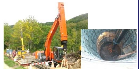
井戸を掘削している様子
