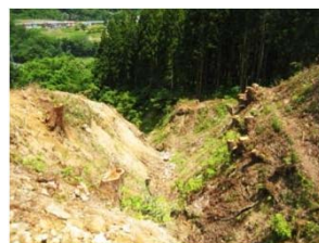
えん堤着工前
