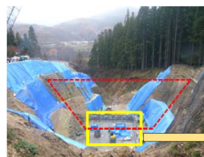
工事の状況 (11月撮影)
