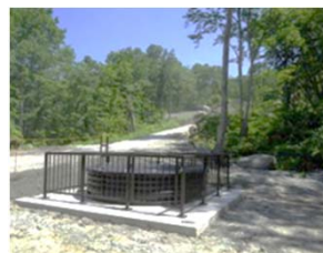
完成した集水井
