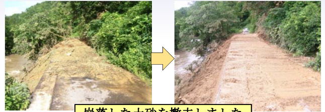
崩落した土砂を撤去しました。
