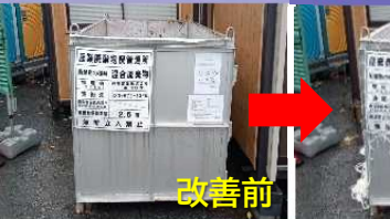
産廃コンテナの飛散防止対策が施されていない
