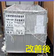
飛散防止用の養生網を設置しました
