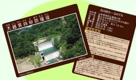
大越第四砂防堰堤 配布場所:道の駅にしかわ
