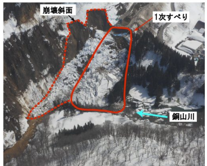
写真-1 1次すべり崩壊直後の空中斜め写真
