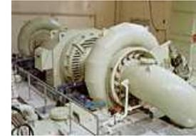
水力エネルギーを有効に活用し、ダムで使用する電気を得るため、水力発電を行っています。最大使用水量8.5m<sup>3</sup>/sで最大出力3,600kwの発電です。余剰電力は東北電力に売電することで年間約2億円以上の経費削減を図っています。
