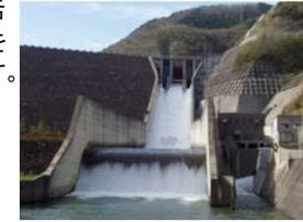
ゲートとは水門のようなもので、上下に開閉して水の量を調整し、適切な貯水量を維持するための設備です。
