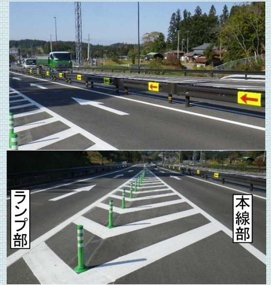
↑路面標示や矢印板で進行方向を明示しています。合流部でUターンしないように、ラバーポールと矢印板を設置しています。
