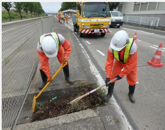
▲ 土砂撤去清掃
